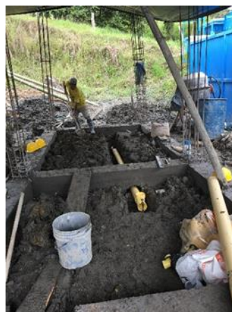
Ilustración 3 Registro fotográfico Tubería PVC sanitaria 4"
