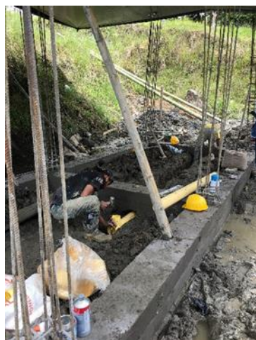
Ilustración 3 Registro fotográfico Tubería PVC sanitaria 4"
