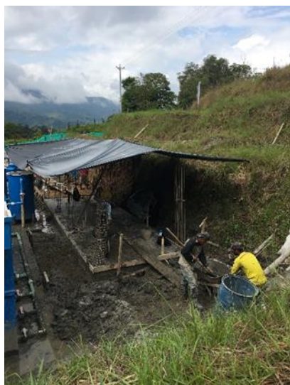
Ilustración 4 Registro fotográfico Alistado en concreto 3000psi e=0.10m
