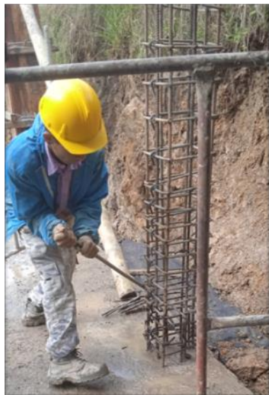
Ilustración 5 Registro fotográfico Armado y fundición de columnas
