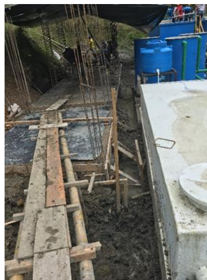
Ilustración 4 Registro fotográfico Alistado en concreto 3000psi e=0.10m
