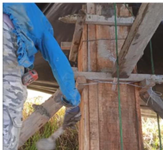
Ilustración 5 Registro fotográfico Armado y fundición de columnas
